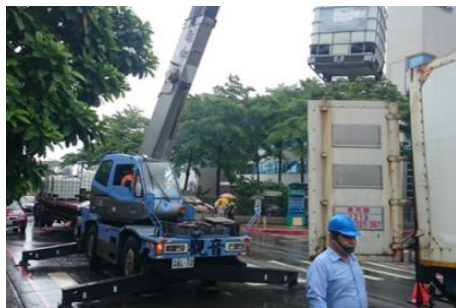
IBC桶吊掛作業
